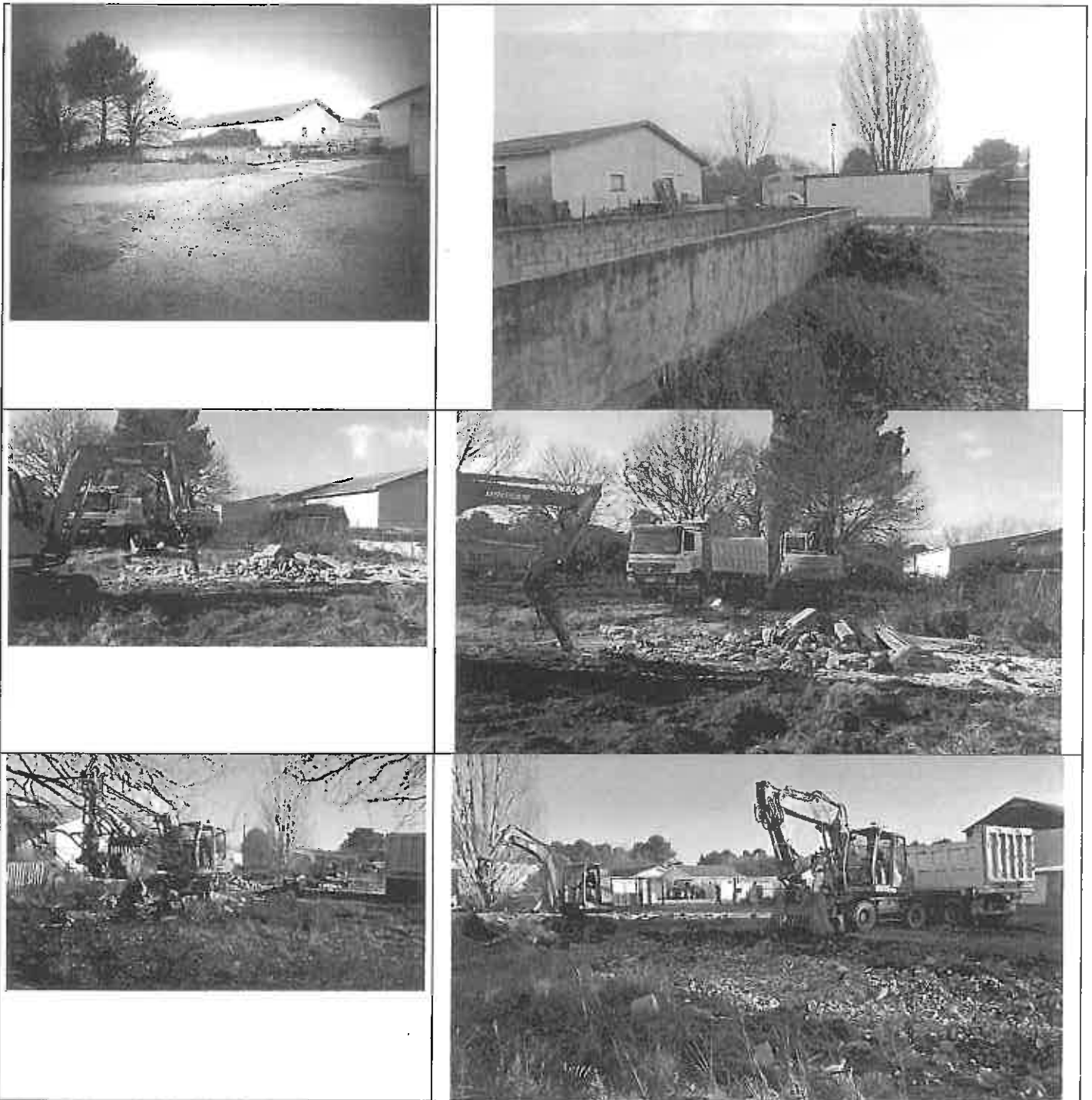
Fig.2 : Vues du dépôt : état actuel au matin du 7 janvier et démontage du site dans la même journée
